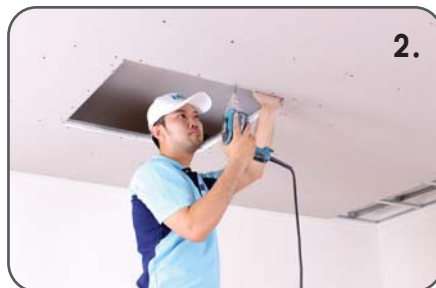
2. เสริมโครงคร่าวเพิ่มความแข็งแรง บริเวณรอบขอบด้านใน
