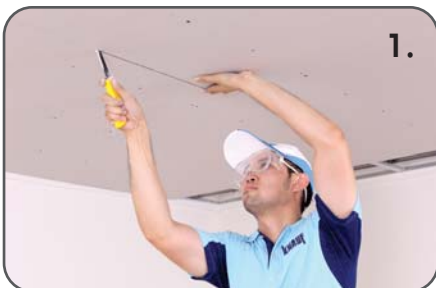
1. เจาะฝ้ายึดขั้วให้พอดีกับช่องเซอร์วิส
