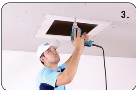
3. ยึดช่องเซอร์วิสเข้ากับโครงคร่าว ปิดฝ้าแทน ฉาบรอยต่อ และลงปูนฉาบ Knauf K Joint ชัดทำสีให้เรียบร้อย
